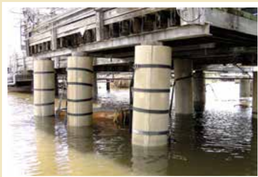
Cimbra en fibra de carbono para refuerzo.
